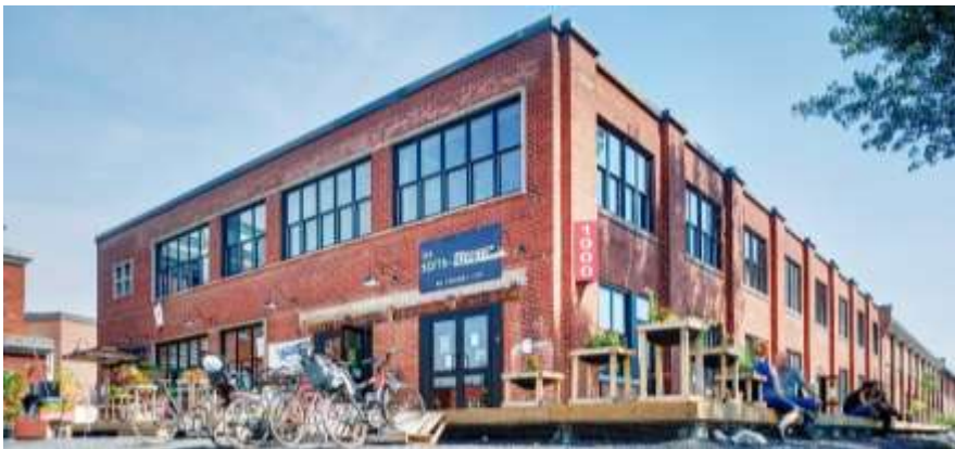
Bâtiment 7 – Montréal, 2018. © Corey Narsted
