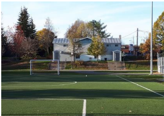
Maison des jeunes-salle des patineurs à démolir
