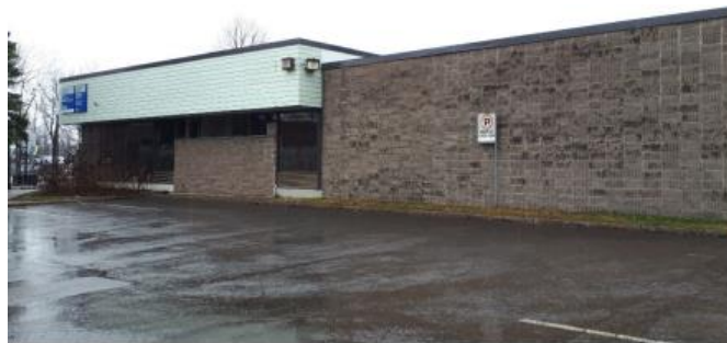
Centre communautaire à démolir, façade avant
