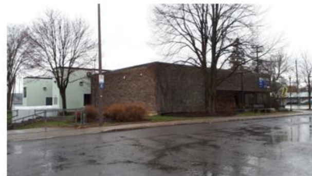
Centre communautaire-bibliothèque St-André à démolir, façade latérale et arrière
