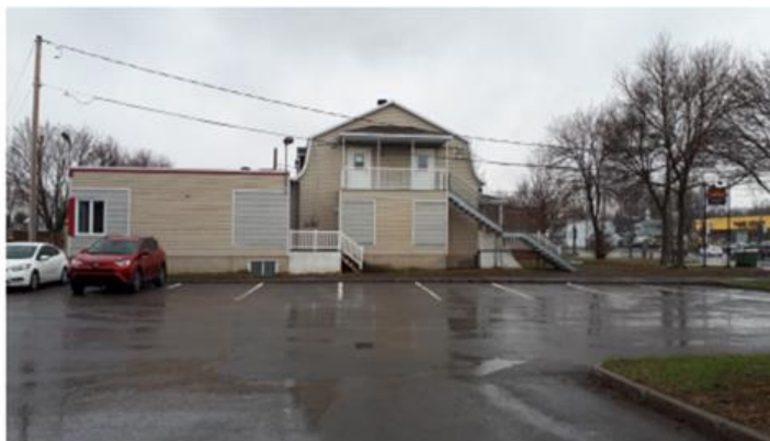
Maison Mauger à démolir
