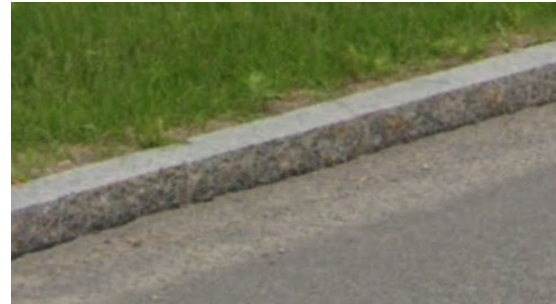
Bordures en granit
