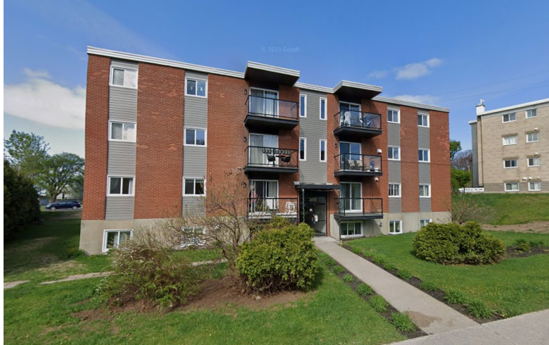
Bâtiment existant de 24 unités
