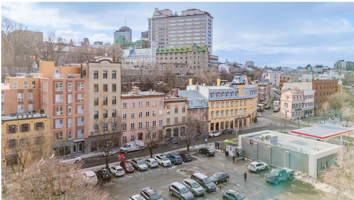
Vue de la rue Saint-Paul et des aires de stationnement faisant face à l'Immeuble.
