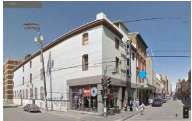
Illustration 4 : Immeuble voisin, côté ouest (intersection Caron/Saint-Joseph)
