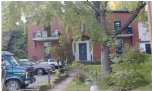
Illustration 1 : démolition complète du bâtiment en arrière-lot
