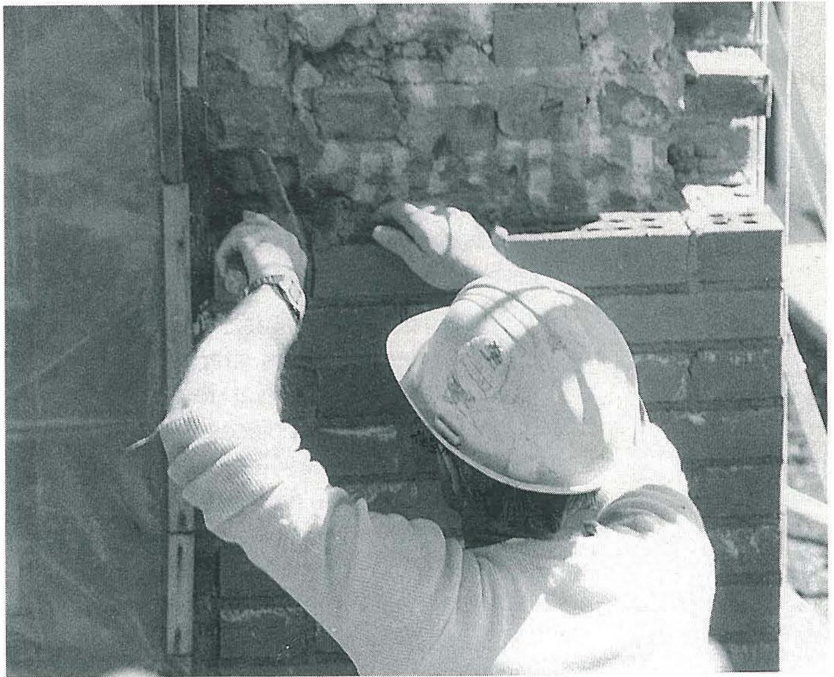
Le démontage d'un mur massif doit se faire délicatement et nécessite parfois l'installation de supports temporaires. Cet étaieement est constitué de poutres et de colonnes réglables, en acier ou en bois. Il doit supporter les charges de la maçonnerie située au-dessus de la partie du mur à refaire, de même que les charges des planchers dont les solives s'appuient sur ce mur.
