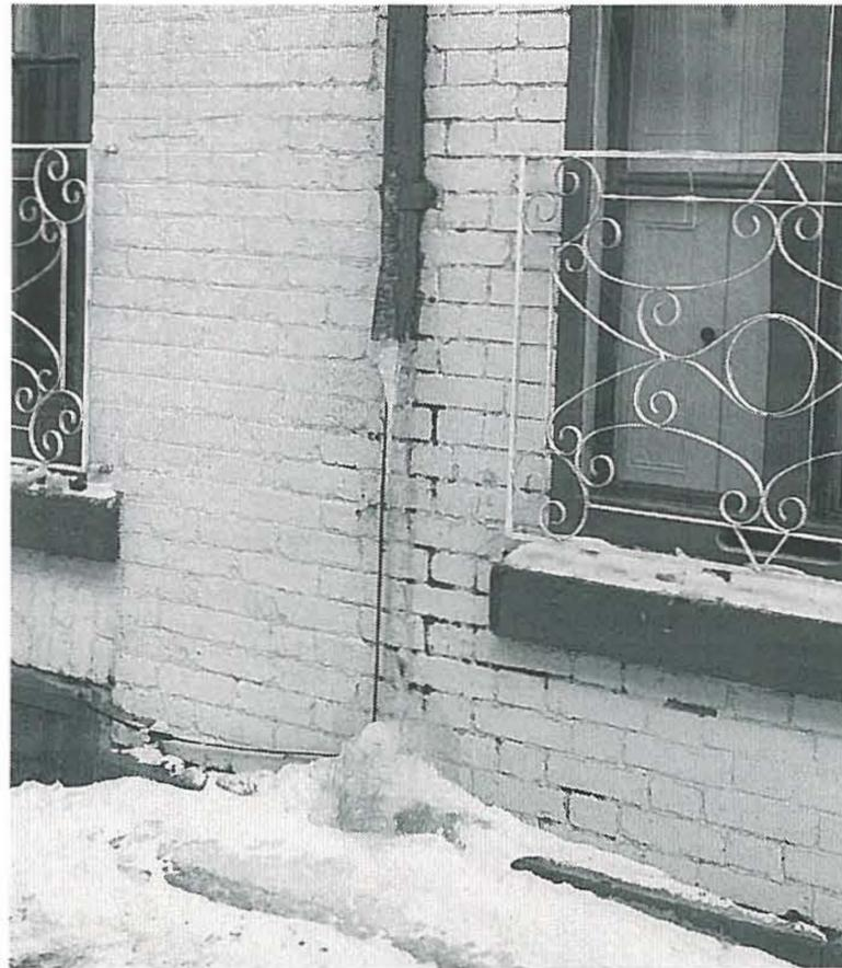
*La dégradation des briques et du mortier se produit souvent au bas des murs ou des gouttières.*
