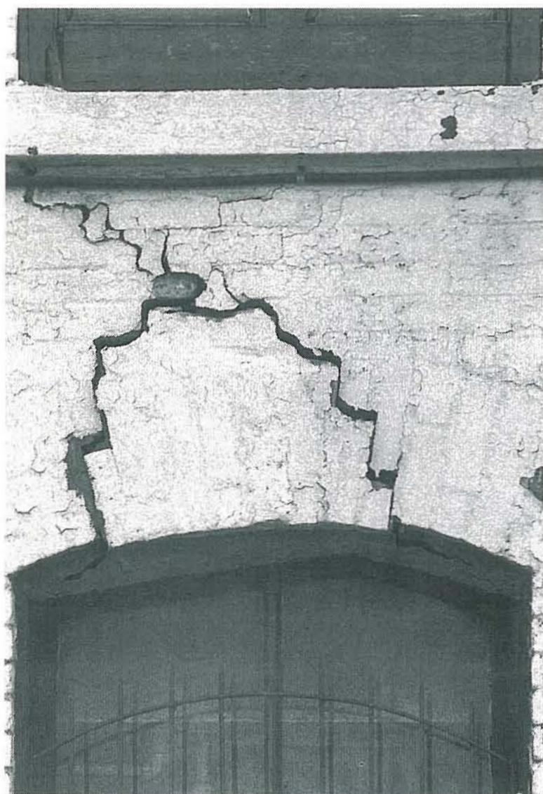
*Une fissure apparaissant au-dessus d'une ouverture peut indiquer une faiblesse dans l'assemblage.*
