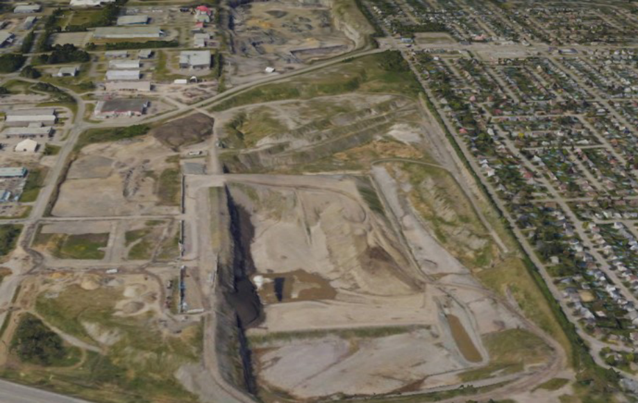
Végétalisation du dépôt à neige de Beauport Vue avant les travaux de verdissement
