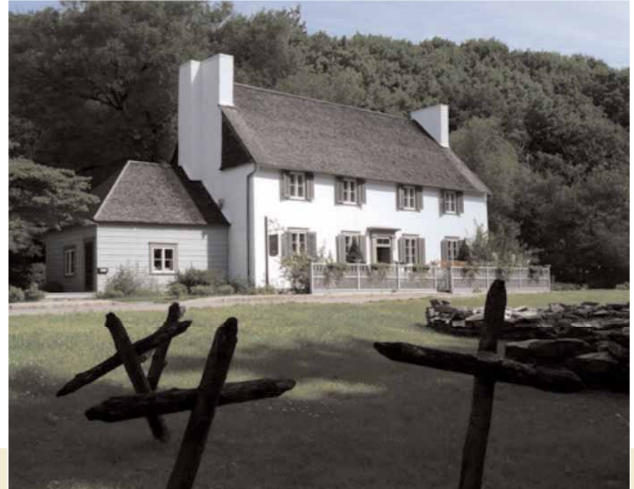
La Maison des Jésuites de Sillery.
