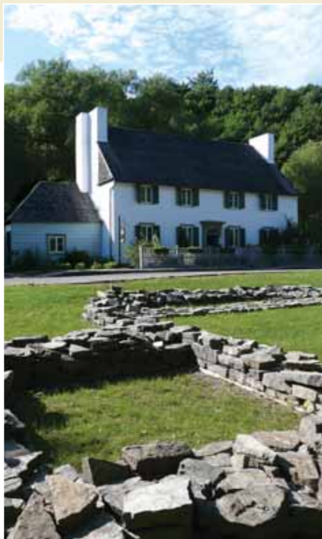
La Maison des Jésuites de Sillery. En avant-plan, le marquage de la chapelle Saint-Michel. Photo : Félix Genêt Laframboise.
