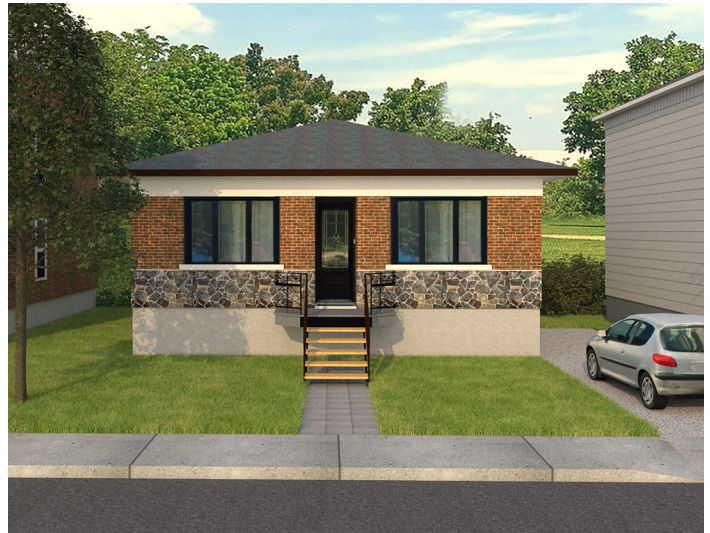
IMAGE 1 – PHOTOGRAPHIE DE L'IMMEUBLE VISÉ PAR LA DEMANDE
