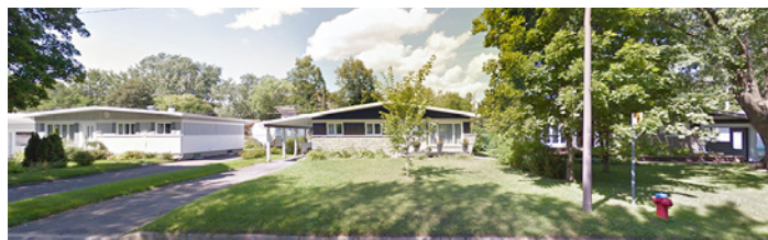
IMAGE 2 – PHOTOGRAPHIE DES BÂTIMENTS ADJACENTS À LA PROPRIÉTÉ PROJETÉE
