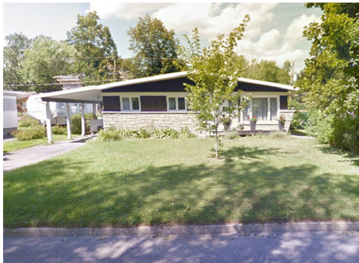
IMAGE 1 – PHOTOGRAPHIE DU BÂTIMENT EXISTANT
