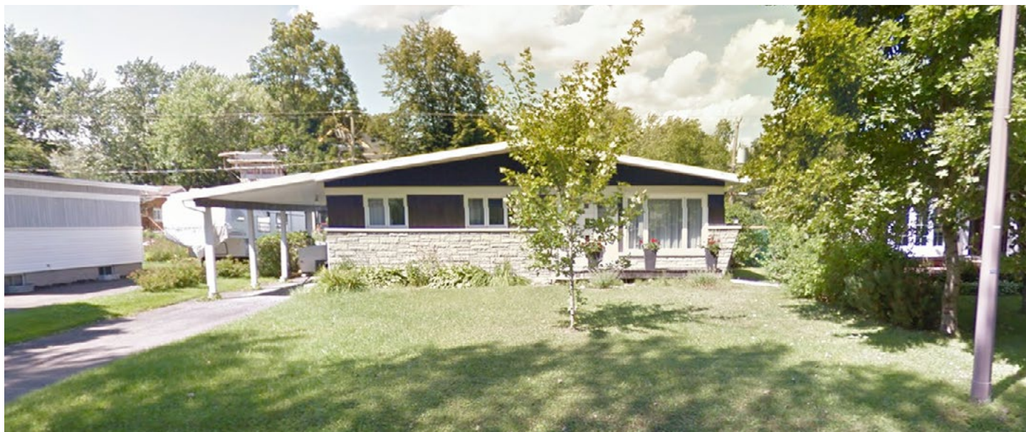
IMAGE 1 – PHOTOGRAPHIE DU BÂTIMENT EXISTANT
