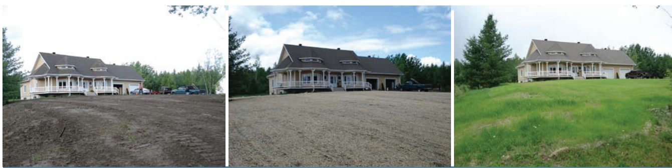
Figure 3. Stabilisation d'un terrain résidentiel avec une couverture antiérosion (Source: Terraquavie, 2010)
