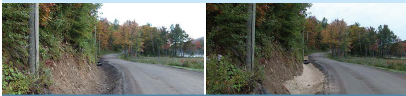
Figure 2. Stabilisation d'un fossé avec une couverture antiérosion (Source: Terraquavie, 2010)
