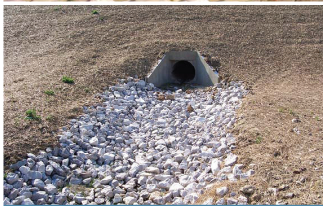
Figure 2. Exemples de protection à la sortie d'un ponceau (Ville d'Edmonton, 2005; UDFCD, 2005)
