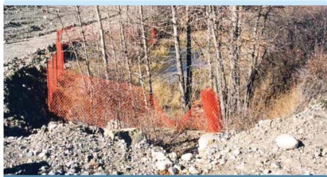
**Figure 1.** Protection des arbres (Ville d'Edmonton, 2005)
