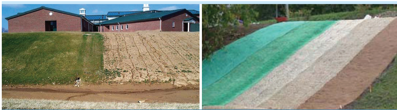
Figure 1. Protection des talus (UDFCD, 2005; Ville d'Edmonton, 2005)
