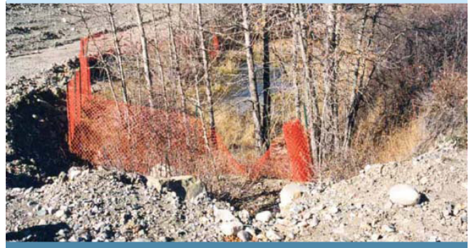
Figure 1. Protection des arbres (Ville d'Edmonton, 2005)
