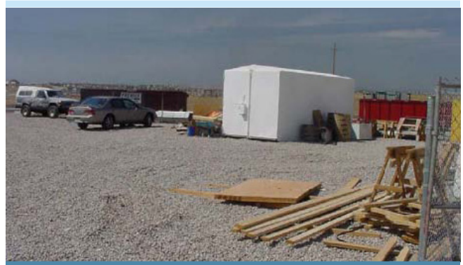
Figure 2. Stabilisation des aires de circulation (UDFCD, 2005)
