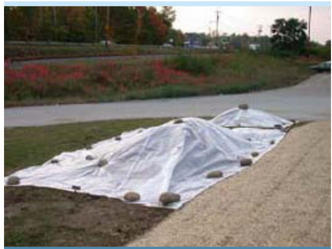
Figure 2. Recouvrement d'une aire de déblais (APEL, 2008)
