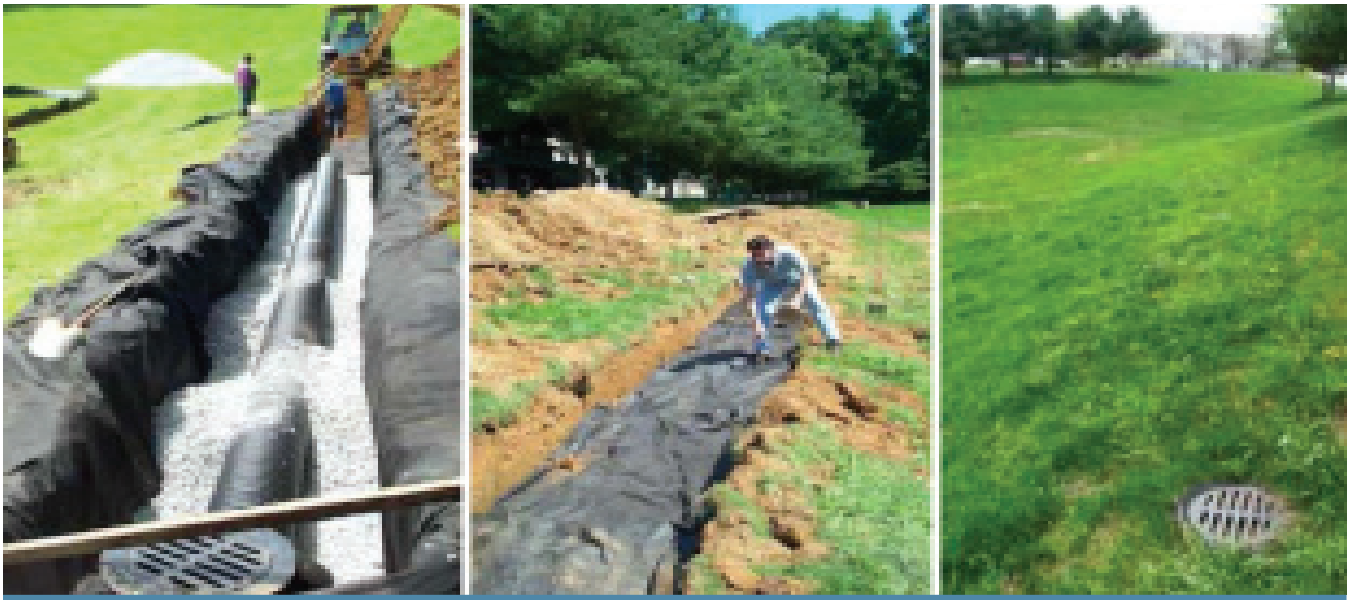
Figure 4. Installation d'un système avec conduite perforée (TRCA et CVC, 2010)
