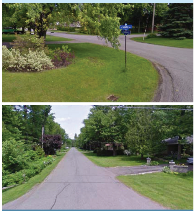
Figure 2. Systèmes avec conduites perforées (Google Street View, réf. du 5 avril 2011)
