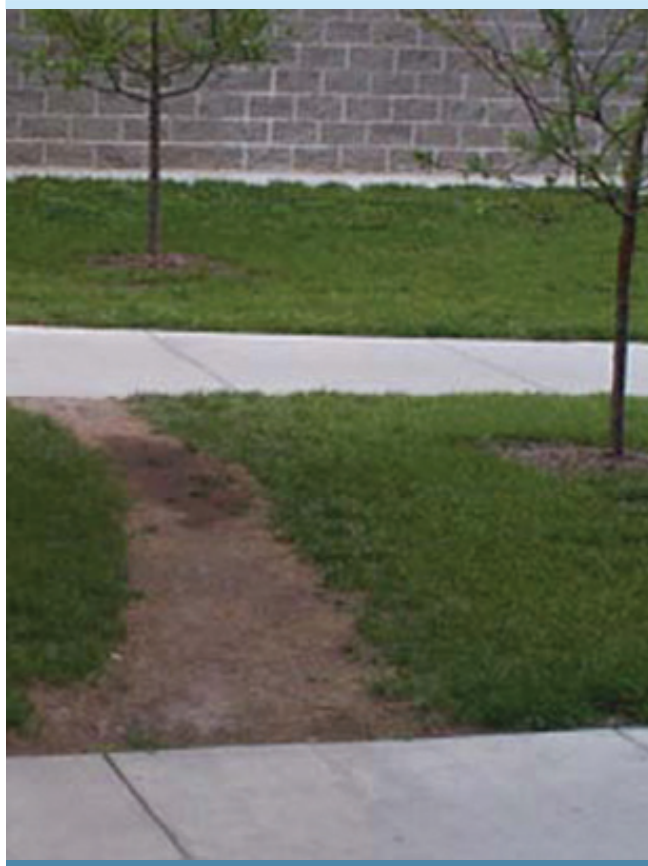
Figure 2. Exemple de surface perméable compactée par le passage des piétons (GVRD et collab., 2005)
