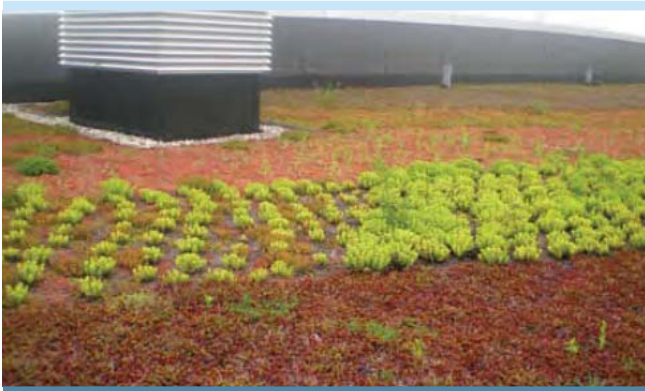
Figure 1. Exemple de toit vert (TRCA, 2010)
