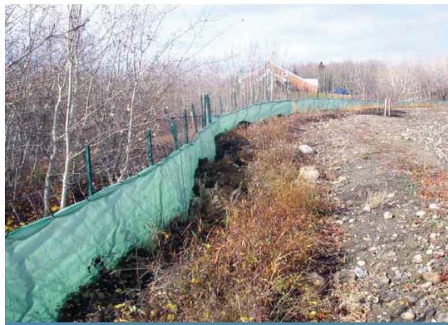
Figure 1. Illustration d'une combinaison d'une bande filtrante et d'une barrière à sédiments (Ville d'Edmonton, 2005)
