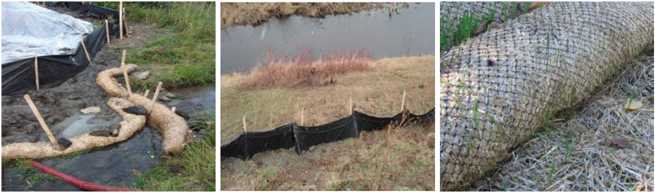
Membrane géotextile attachée à des supports à intervalles réguliers et boudins de pailleis
