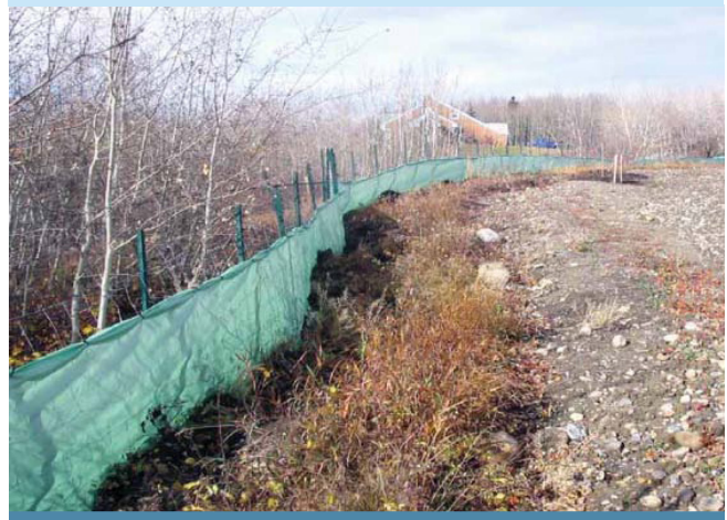
Figure 1. Illustration d'une combinaison d'une bande filtrante et d'une barrière à sédiments (Ville d'Edmonton, 2005)
