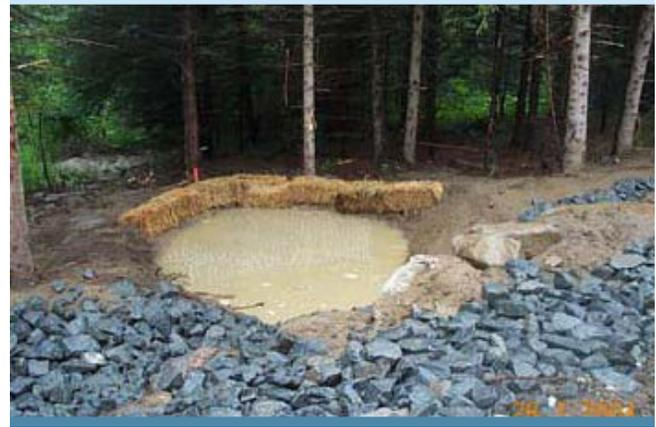
Figure 1. Exemple de trappe de sédimentation (Abrinord, 2008)
