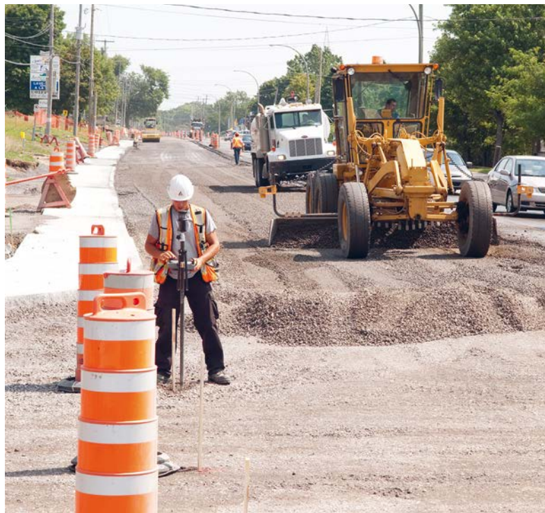
D'ici la fin de l'année, ce sont 850 chantiers qui seront déployés pour améliorer nos infrastructures routières et urbaines.
