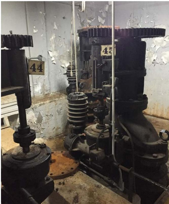
**Figure 3 – Exemples d'une valve hydrostatique**
