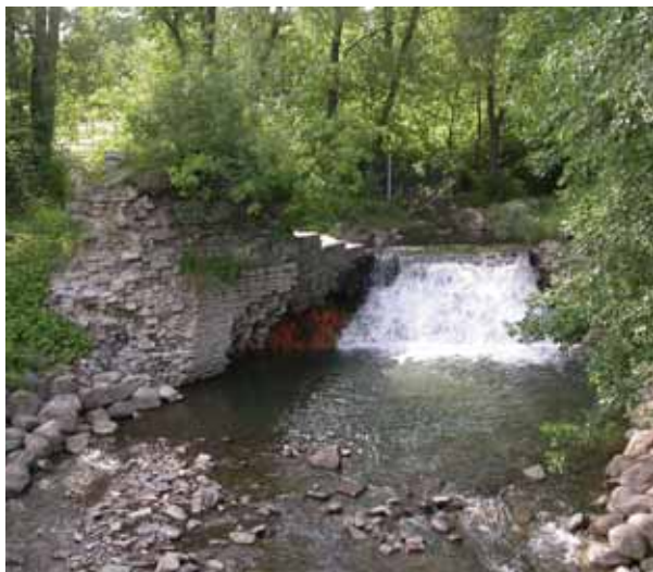
Les vestiges du barrage du moulin Brown. Photo : Les Alliés, 2004.
